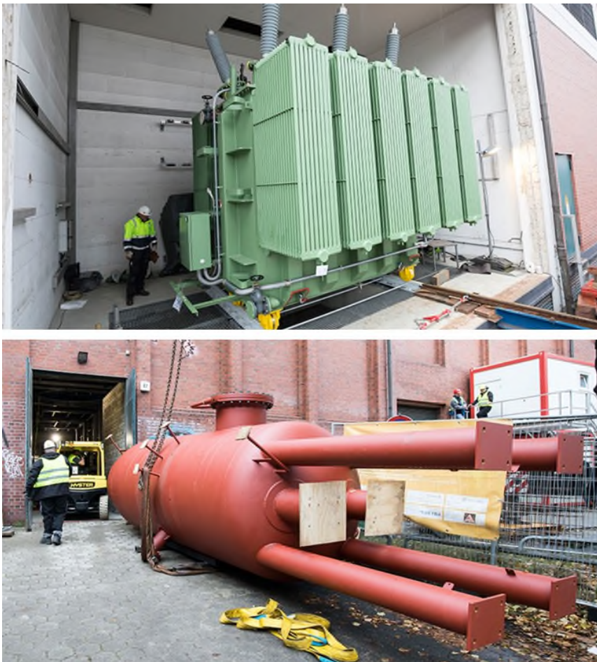
Abbildung 23: Elektroheizkessel „Karoline“ – eine 45-MW-PtH-Anlage im Hamburger Karolinenviertel wird in ein Umspannwerk eingebaut (unten). Die Anlage liefert als Teil des Projektes NEW 4.0 einen Beitrag zur norddeutschen Energiewende. (Quelle: Vattenfall 2018)
