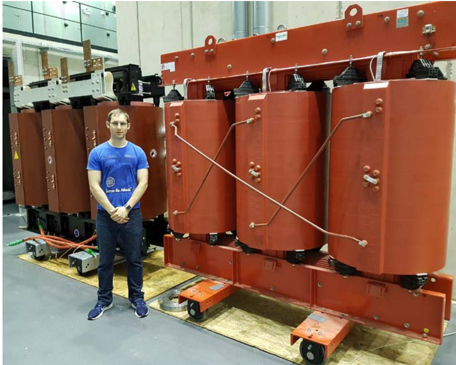
4,5 MVA, 50 Hz Transformator 11.500 kg (2,5 kg/kVA)
