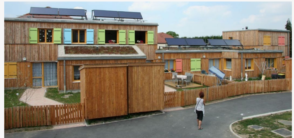
INSTALAȚII SOLARE ÎN FOSTUL ORAȘ MINIER LOOS-EN-GOHELLE, DEZVOLTATE PRIN PARTENERIAT PUBLIC-PRIVAT (PPP)
