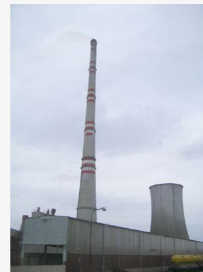
ELEKTRÁRNA NOVÁKY NA SLOVENSKU, JÍŽ PROVOZ BUDE ZASTAVEN V ROCE 2024
