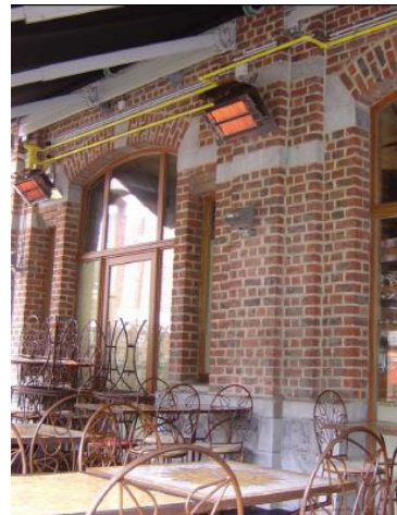
Figure 10 : principe de fonctionnement et photo d'un chauffage par rayonnement infrarouge. (Source : www.thermico.be)
