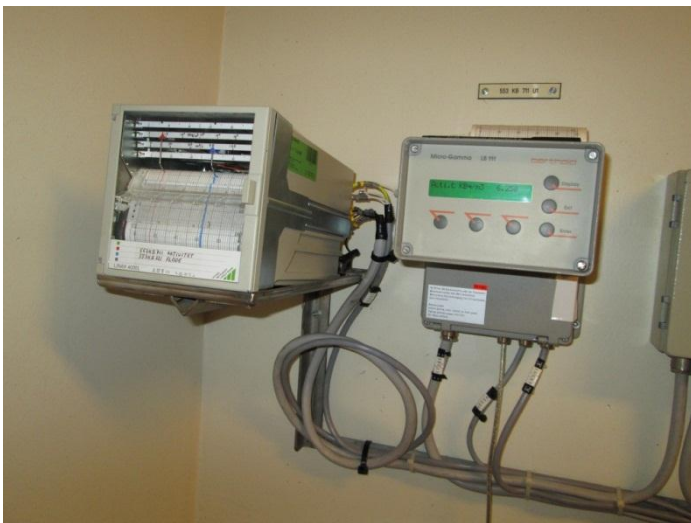
Figur 4. Kr-85-skärm för system för övervakning av luftutsläpp
