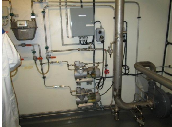
Figur 3. Clabs huvudskorsten samt provtagnings- och övervakningsutrustning för luftutsläpp.
