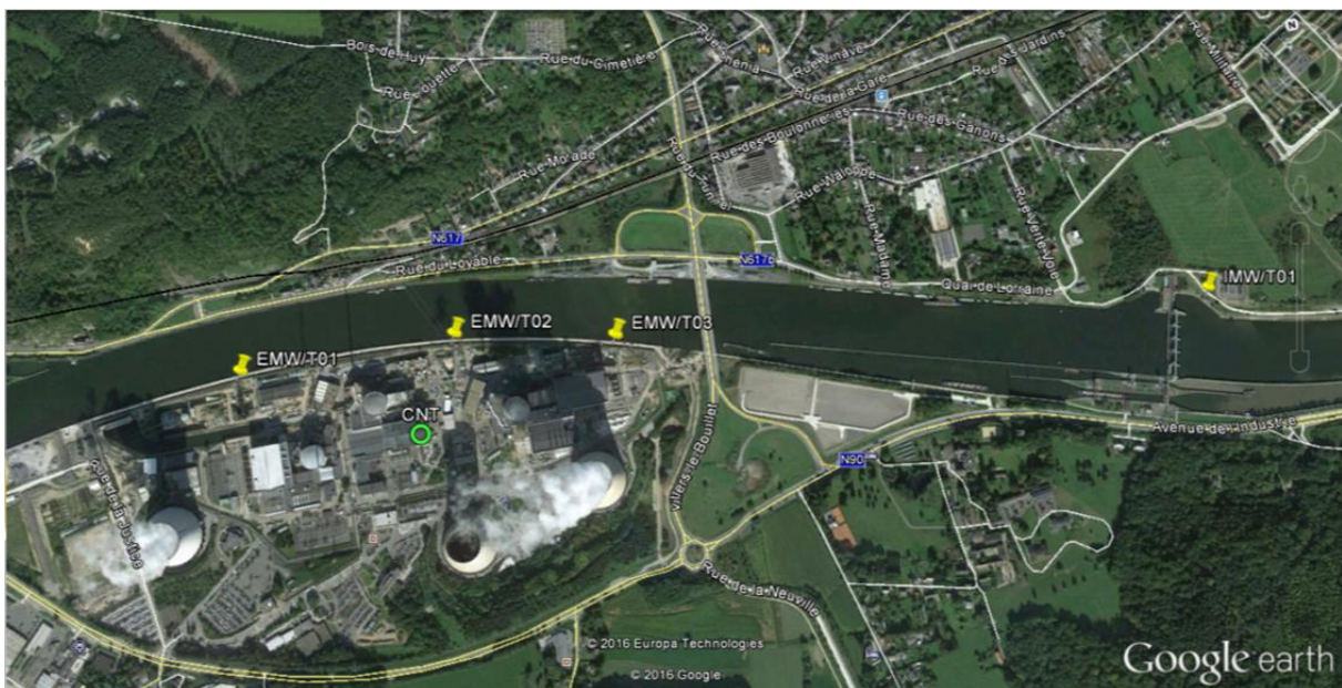
Figure 11 Stations de contrôle radiologique de l'eau au voisinage de la centrale de Tihange
