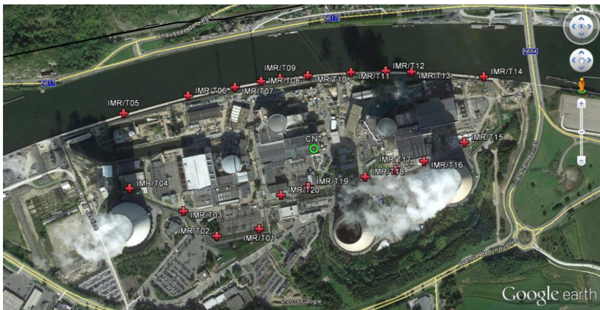
Figure 9 Stations TELERAD de mesure périphérique et de contrôle de la radioactivité dans l'eau à la centrale de Tihange
