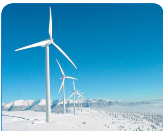
Vestas WEC at Tauernwindpark Oberzeiring (Coordinator Energiewerkstatt GmbH).
