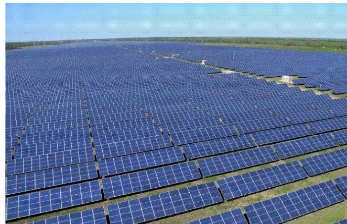
Solar Station «Belarusneft», 56 MW, Gomel region
