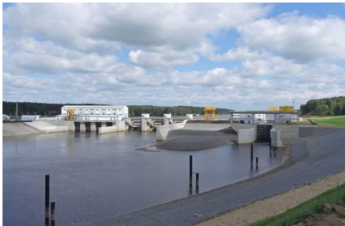
Vitebsk HPP 40 MW
