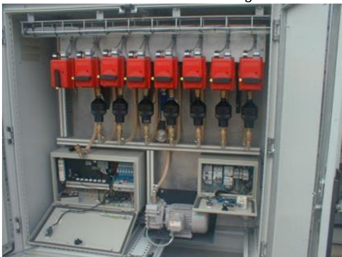
Abbildung 13. Luftprobensammler mit Filtern für jeden Wochentag
