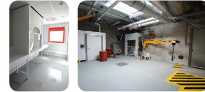
Acheminement des colis depuis le bâtiment regroupement
