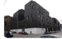
6- Edificio M10 - Mayacina
